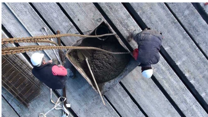
Marcel Dinahet, Vue du chantier du Frac Bretagne, février 2010 © Marcel Dinahet
